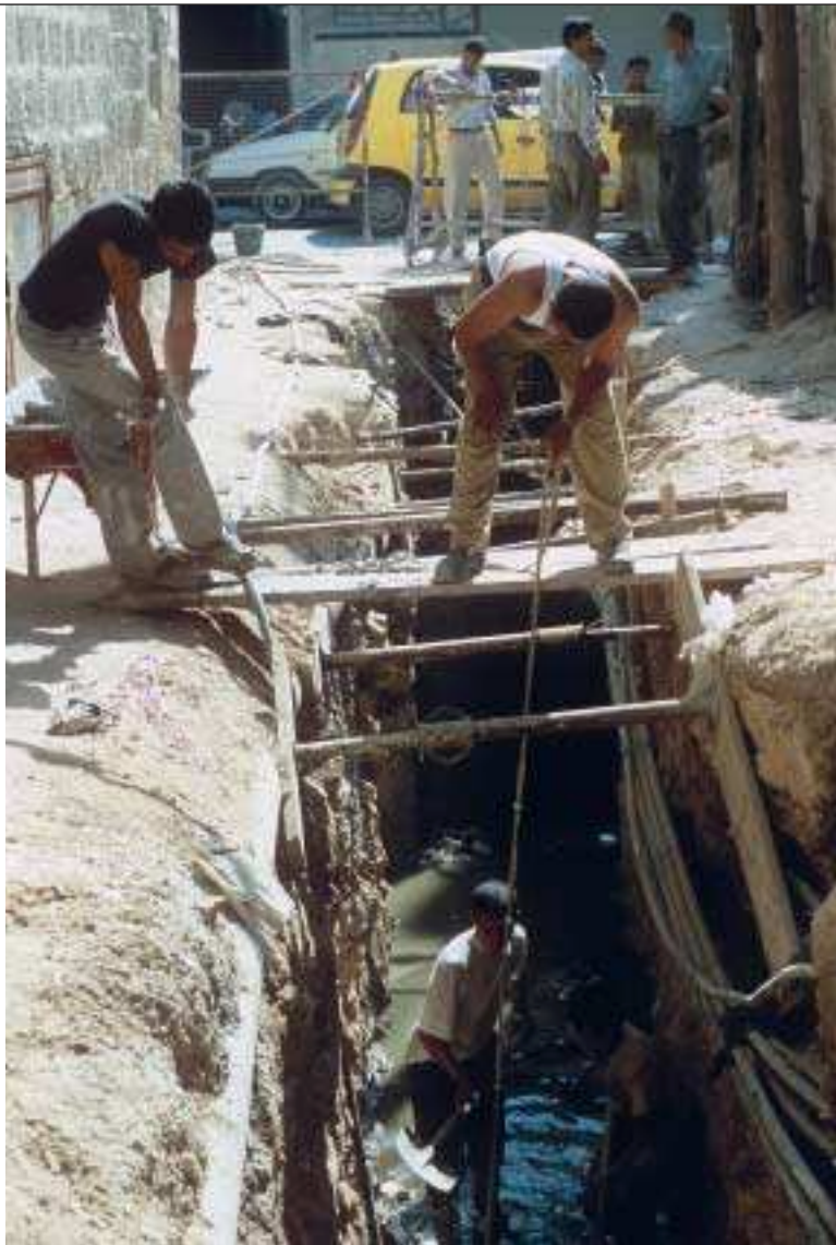
Infrastruktur: Beim Tor Bab al Maqam werden neue Wasserrohre gelegt.
